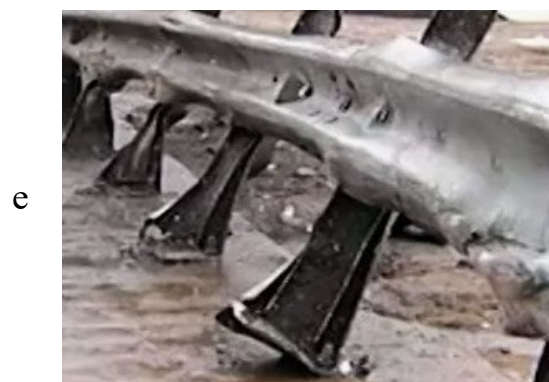
Рисунок Г.5 – Характерные повреждения тросовых дорожных ограждений: а, б – деформация элементов; в, г – разрушение соединений; д – разрыв балки и вырыв стойки из грунта; е – отрыв стоек мостового ограждения от основания
