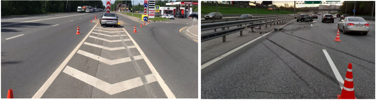
Рисунок Г.3 – Следы ТС на дорожном покрытии
