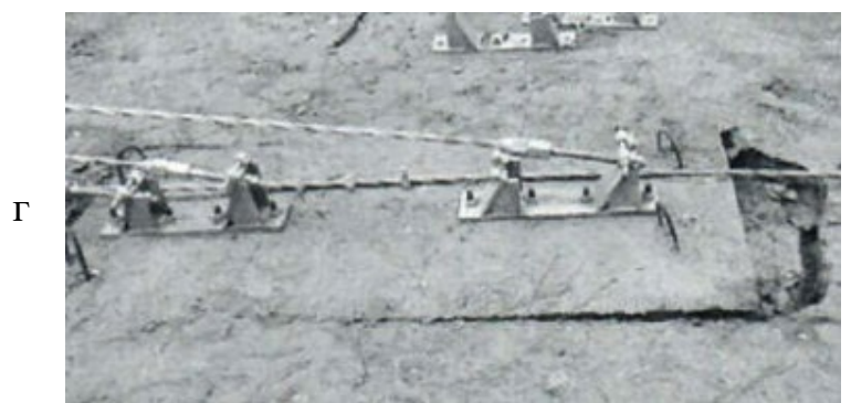
Рисунок Г.6 – Характерные повреждения тросовых дорожных ограждений: а, б – деформация / разрушение стоек; в – локальное повреждение троса; г – место анкеровки
