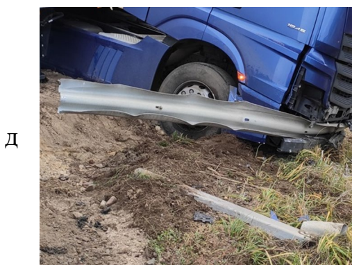
Рисунок Г.5 – Характерные повреждения тросовых дорожных ограждений: а, б – деформация элементов; в, г – разрушение соединений; д – разрыв балки и вырыв стойки из грунта; е – отрыв стоек мостового ограждения от основания
